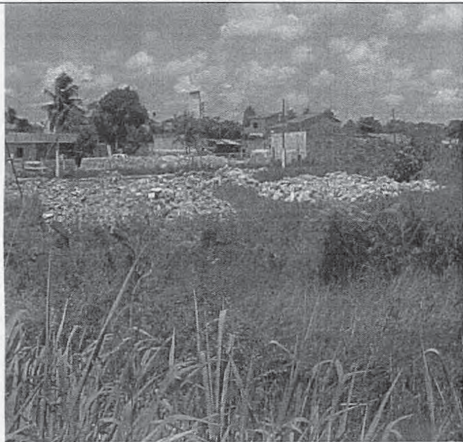
Foto 11: Aterro concluído em 05.04.2007 – Ao fundo vê-se a Rua Santa Marta
