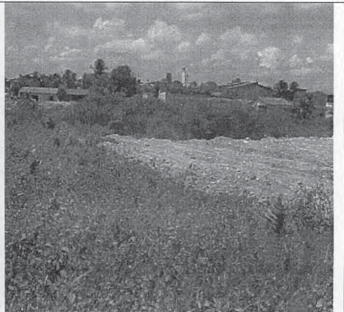
Foto 12: aterro concluído em 05.04.2007 Ao fundo: Depósito Paulo Só Pedras
